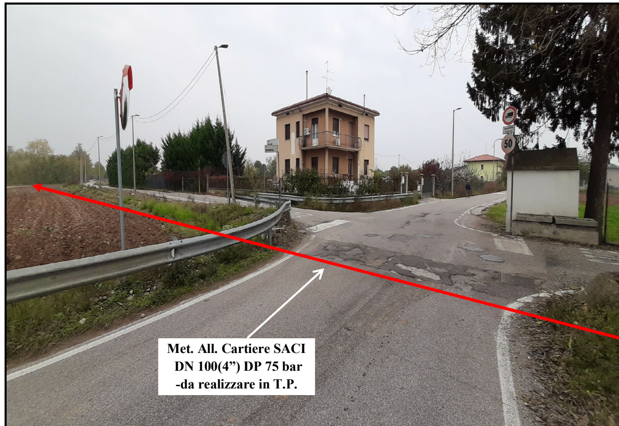
Foto 2: Vista del metanodotto in attraversamento a Via Gelmetto (da realizzare in trivella/spingitubo)
